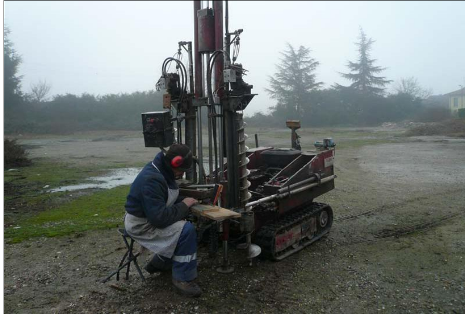
Foto 7-Prova penetrometrica dinamica SCPT2
