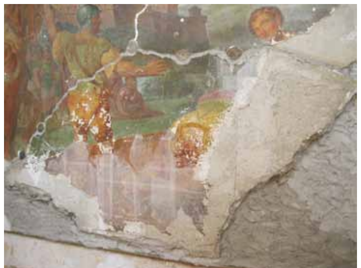
Ricollocazione del frammento staccato nella sua ubicazione originale. Nella foto sono visibili anche la fase di stuccatura di profondità delle lacune e l'asportazione della velinatura protettiva.
